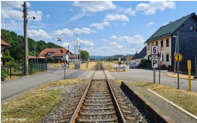
Abb. 2: Ortsbegehung BÜ Niederschmalkalden
