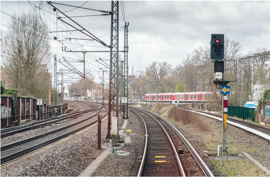
Abb. 3: Streckenausrüstung S-Bahn-Strecke mit Ne 14 und Balisen
