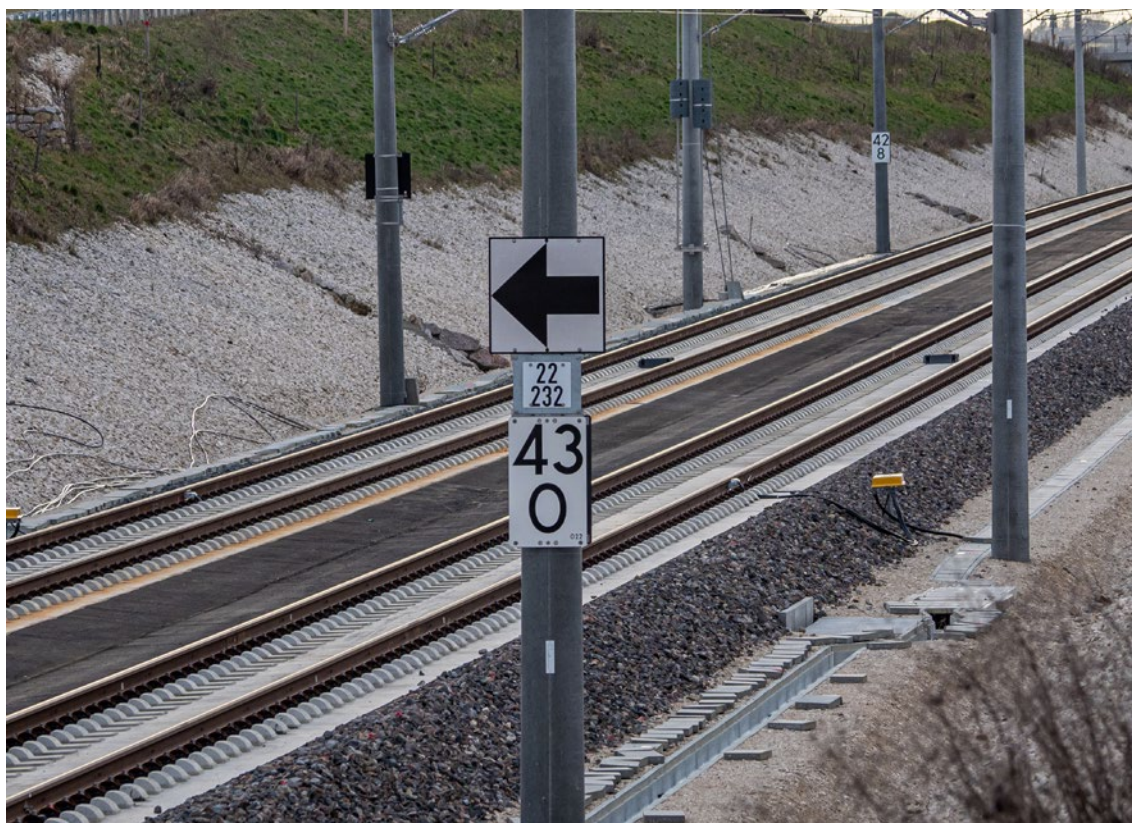
Bild 2: Ein Blockkennzeichen neuer Bauform (ETCS location marker)
