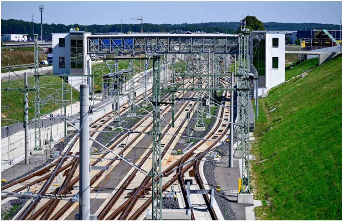
Bild 3: Der viergleisige Personenbahnhof Merklingen
