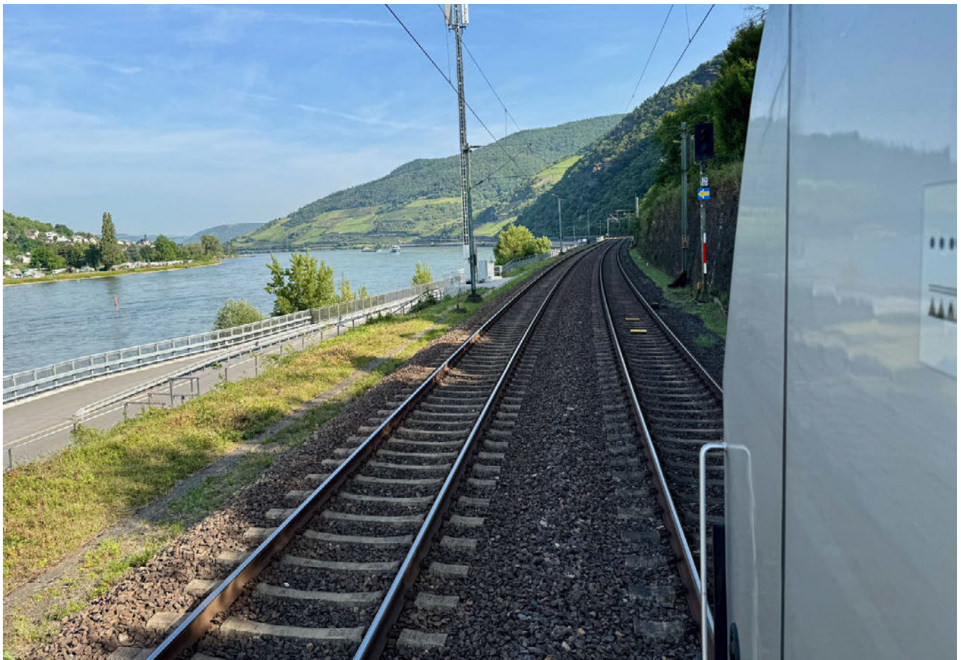
Bild 1: Blick aus der Vectron auf den Rhein mit Balisen, Ne14 Tafel und dunkelgeschaltetem Signal
