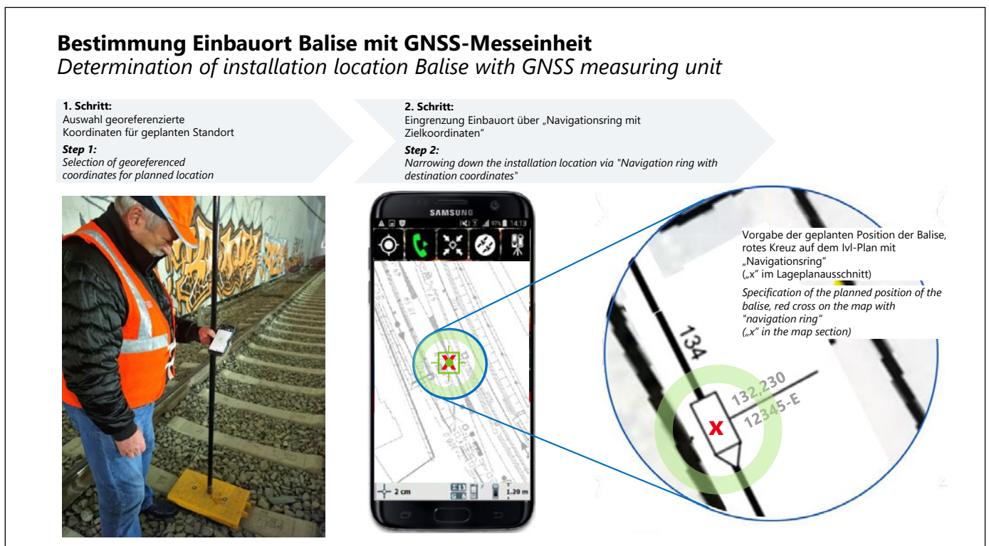
Bild 3: Bestimmung Einbauort Balise
