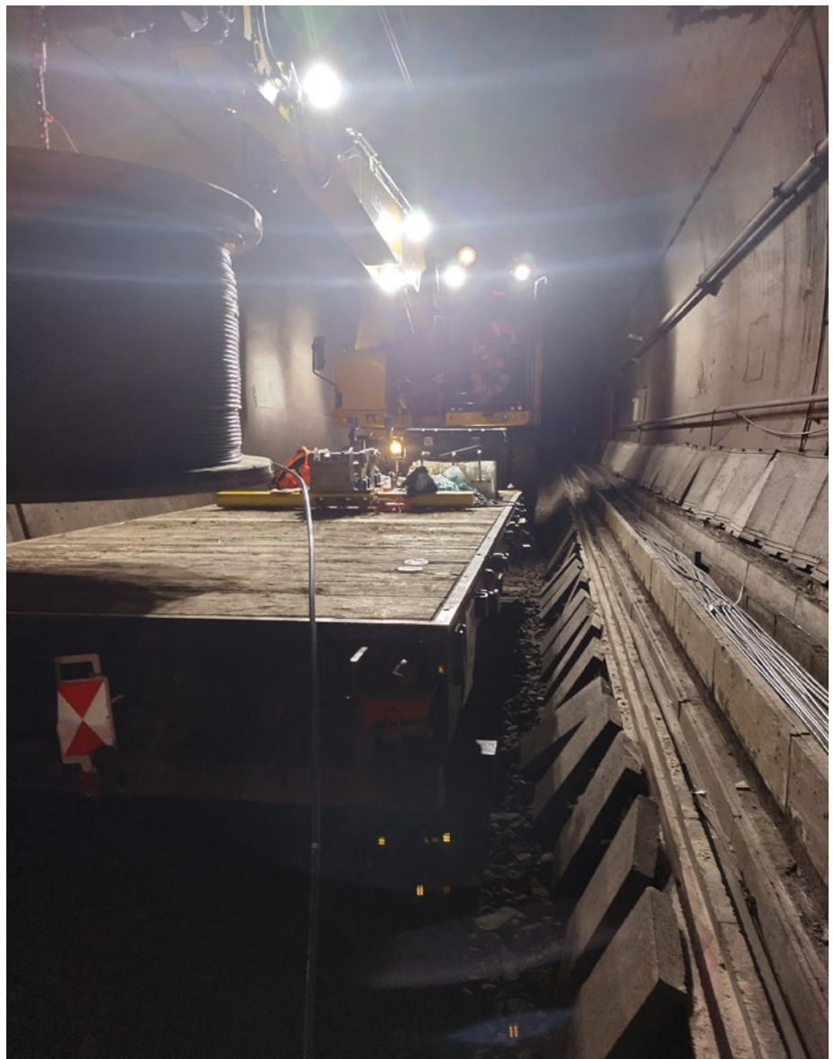
Abb. 2: Kabelzug auf der S-Bahn-Stammstrecke, im August 2023
