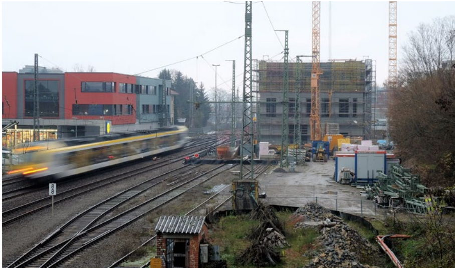
Abb. 2: Bedien- und Technikstandort Waiblingen im Bau (Bauzustand 10. Dezember 2022)
