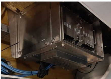
Abb. 3: Im Deckenbereich einer S-Bahn der Baureihe 423 eingebauter ETCS/ATO-Fahrzeugrechner (EVC)
