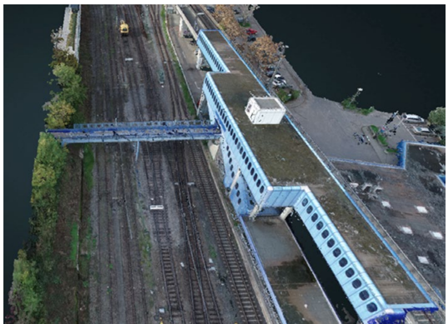
Abb. 3: Bild aus Befliegung des Bahnhofs Stuttgart-Zuffenhausen Quelle: Auszug aus Drones2BIM; DB
